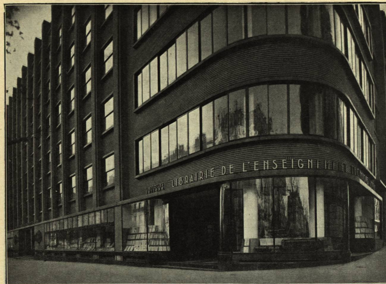
L'ÉCOLE DES TRAVAUX PUBLICS Un coin de la façade et l'entrée de la librairie de l'enseignement technique (Photo Kollar) (Bétons Armés Hennebique)
